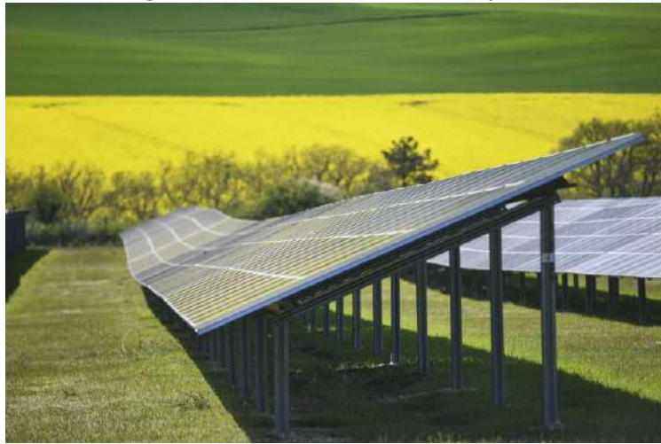
Figure 6 : Panneaux sur structure gabion
